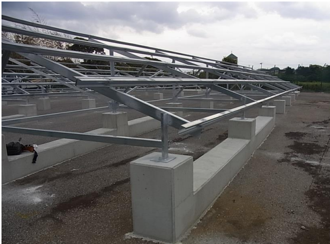
基礎及び架台設置
