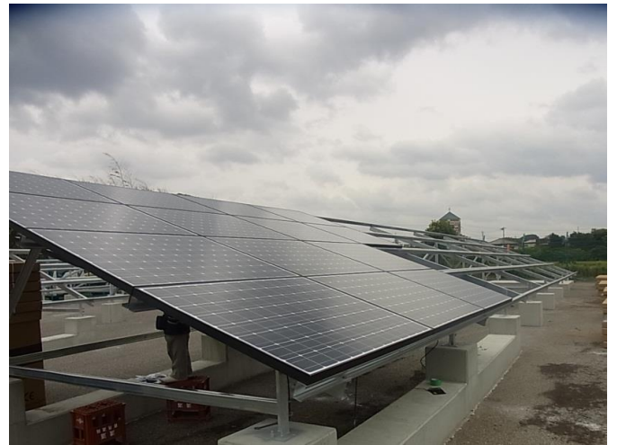
太陽光パネル取付
