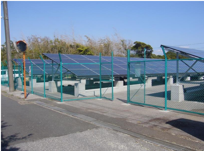
フェンス設置
