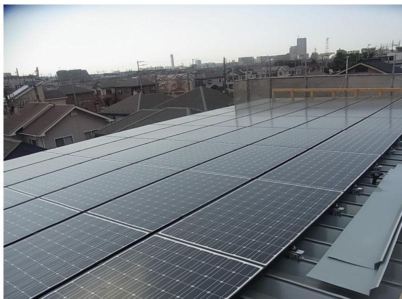
太陽光パネル取付
