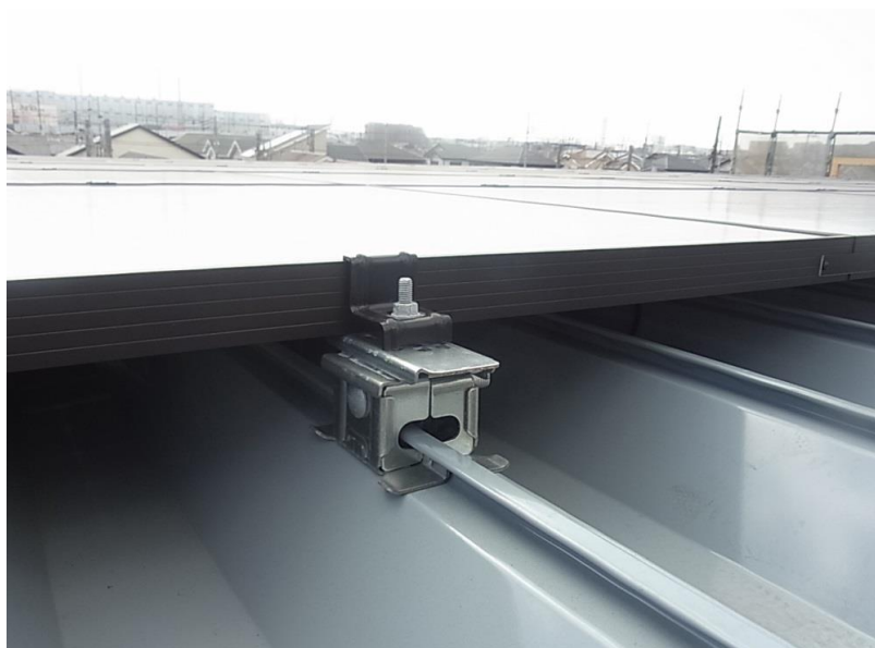
既存ハゼ折半取付金具設置
